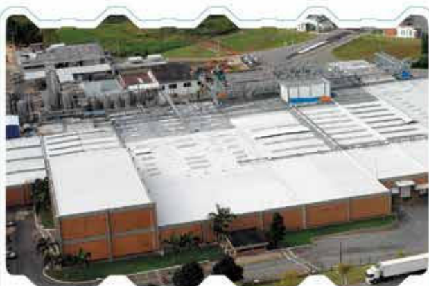
TODOS OS TIPOS DE COBERTURAS - Danone (MG)
